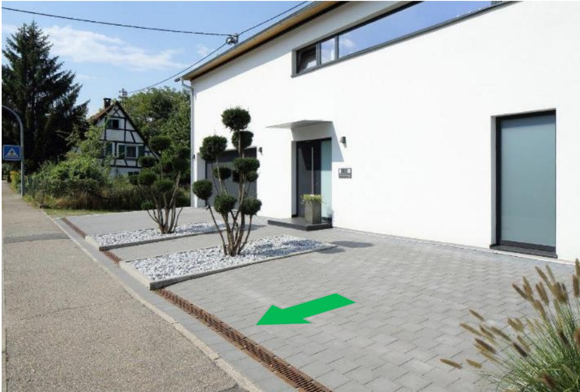
**Zusätzliche Entwässerung für Oberflächenabflüsse vorsehen (Starkregenereignisse, abnehmende Durchlässigkeit)**
