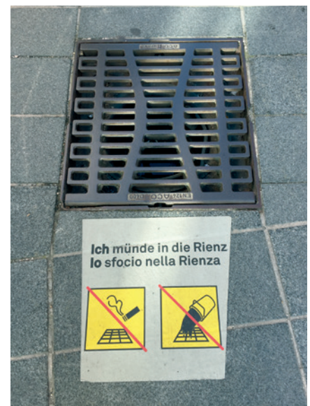
Kennzeichnung von Straßenabläufen in der Fußgängerzone von Bruneck (Südtirol)
